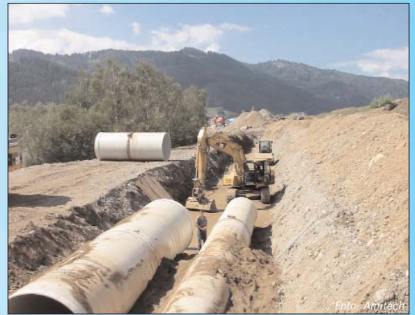
Die zwei unterschiedlich großen Druckrohrleitungen (Dn 1.600 mm und DN 2.400 mm) wurden parallel zum Maschinenhaus verlegt.
