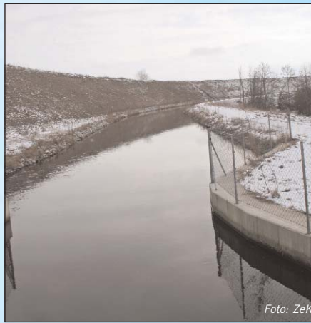
Das Ausleitungsgerinne wurde naturnah gestaltet
