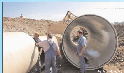
Geringes Rohrgewicht bedeutet rasche Verlegung
