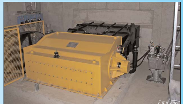
Eine WKV-Durchströmturbine arbeitet das Restwasser ab.
