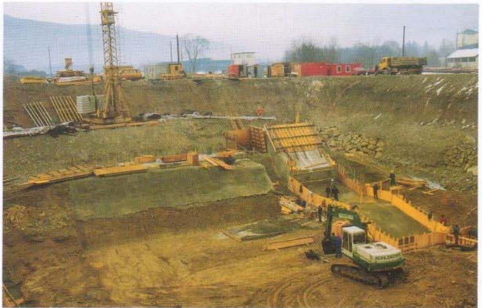
Herstellen der Kraftwerksfundamente in der trockenen Baugrube
